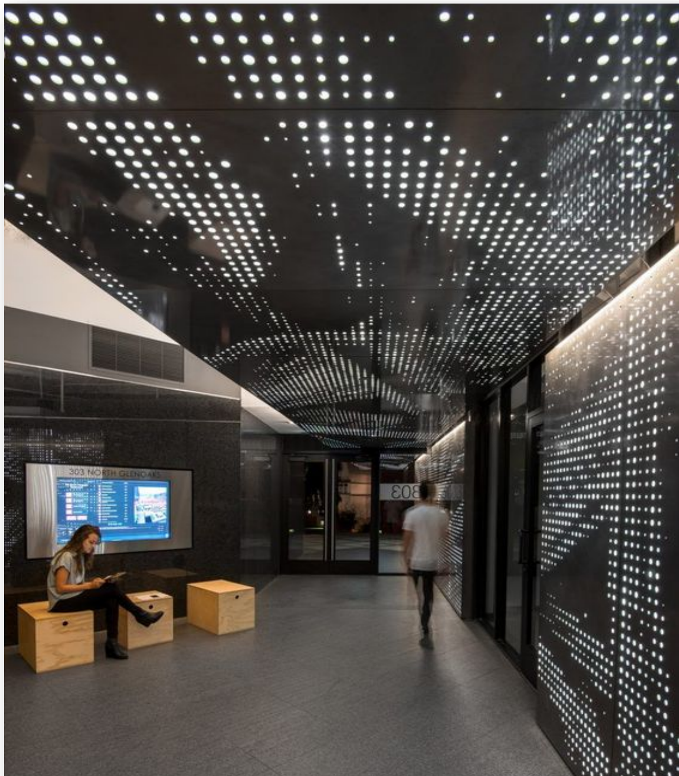
უწყვეტი პერფორირებული ჭერი ინდივიდუალური ზომა; ფერი - RAL & ხის ფაქტურა; სისტემა - უხილავი კონსტრუქცია;
