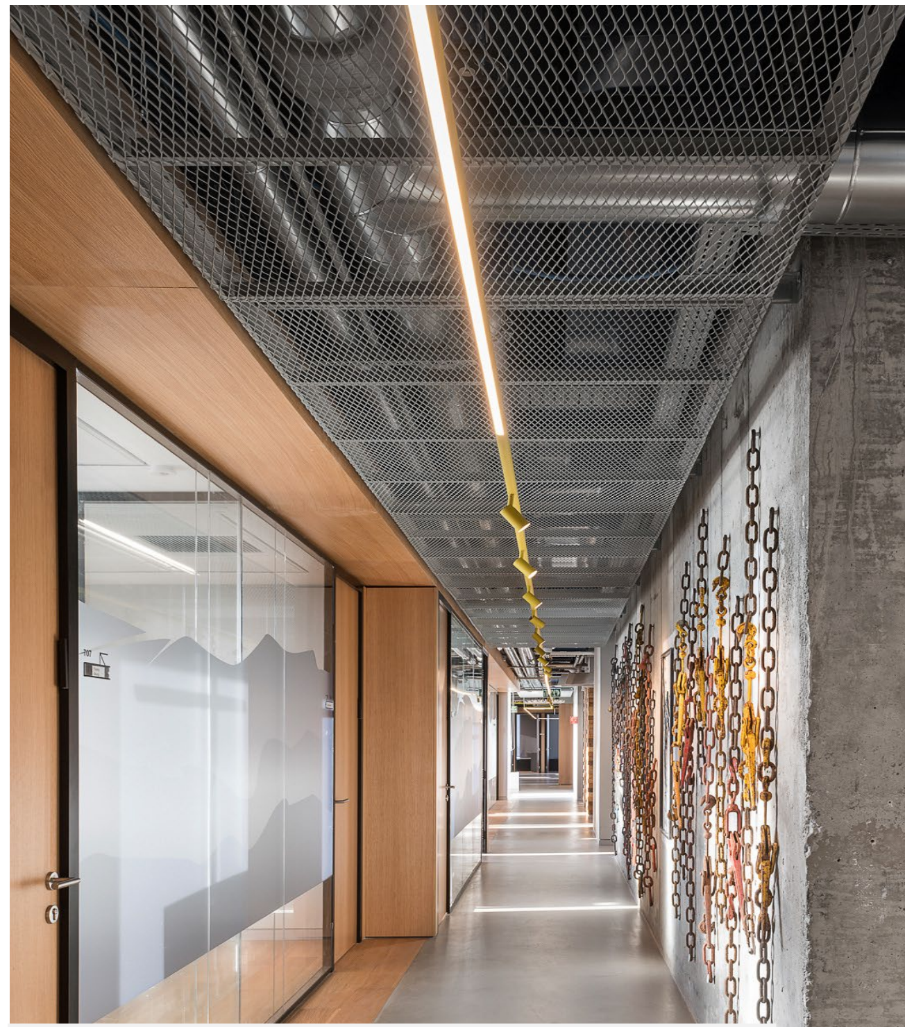
სისტემა - ხილული T24 - lay on; უხილავი clip-in; დაკიდული - hook on • შესაძლებელია განათების ინტეგრაცია; • შესაძლებელია კედელზე მონტაჟი;
